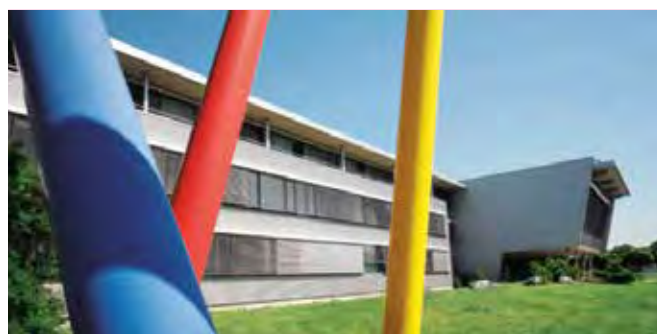
Die Zentrale des Luftfahrt-Bundesamtes in Braunschweig
